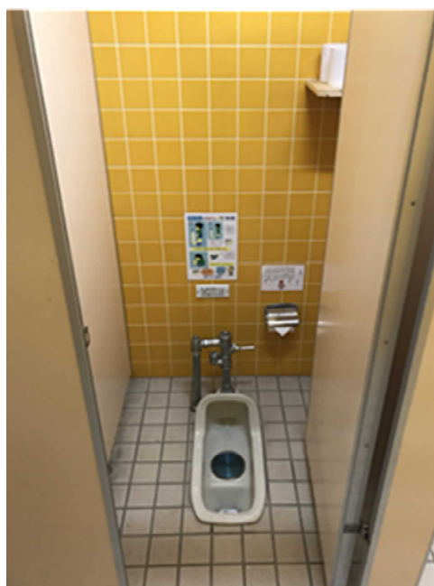
和式トイレ（熊野第二小学校）
