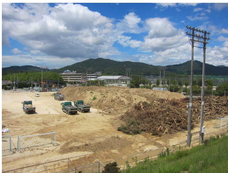
(土砂や流木等を搬出される作業が長期に渡り続けられた)
