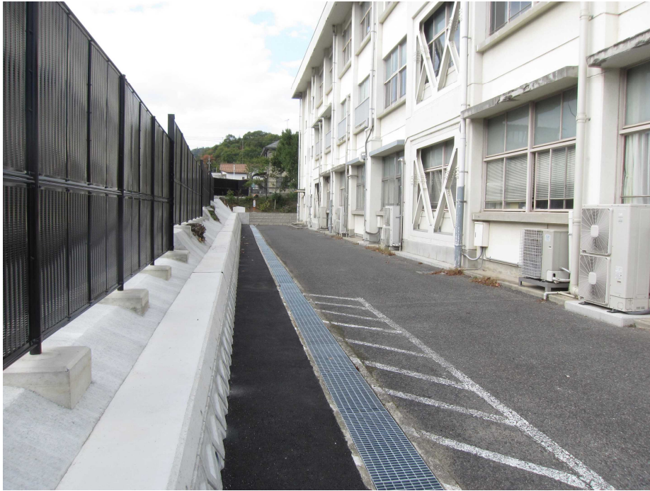
(正門から西側を望む：道路幅員も広がり、給食運搬車両等の通行も容易に)
