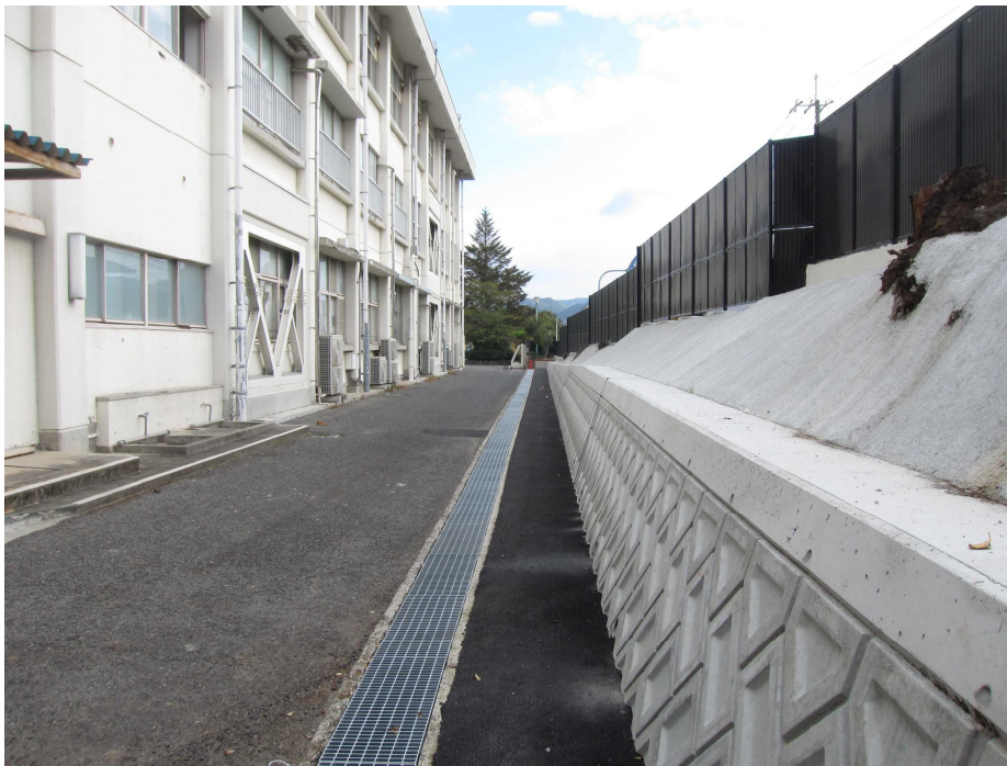
(西側から正門側を望む：幅員も4 m確保され離合も可能となった)
