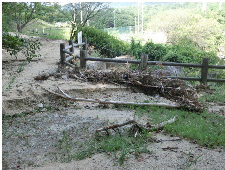
(災害で発生した土砂に埋まった多目的グラウンド)
