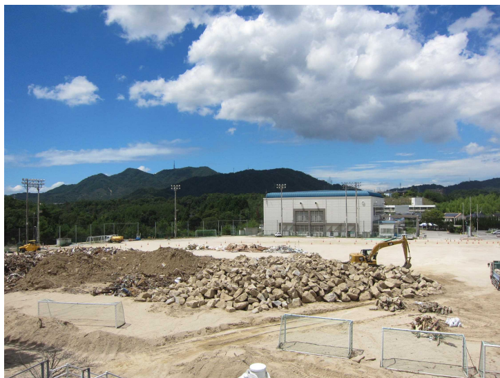
(平成 30 年 7 月豪雨災害の土砂やがれき等の搬入場所として使用され、その後、撤去が進んでいる様子)
