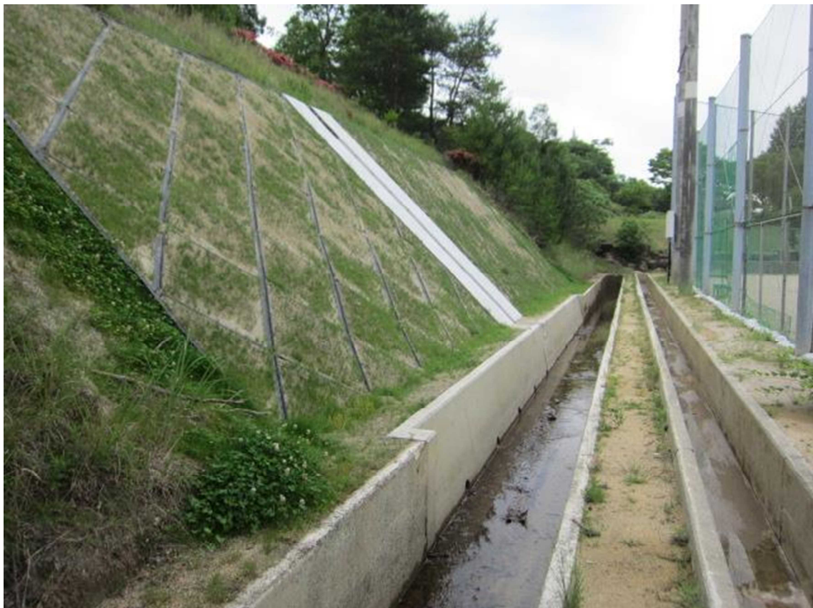
(復旧工事が完了した縦型側溝の様子)
