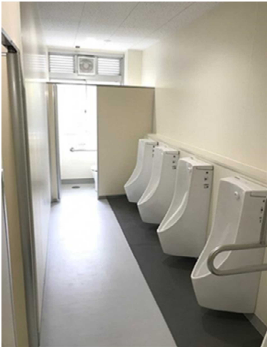
乾式の床となった男子トイレ（熊野中学校）
