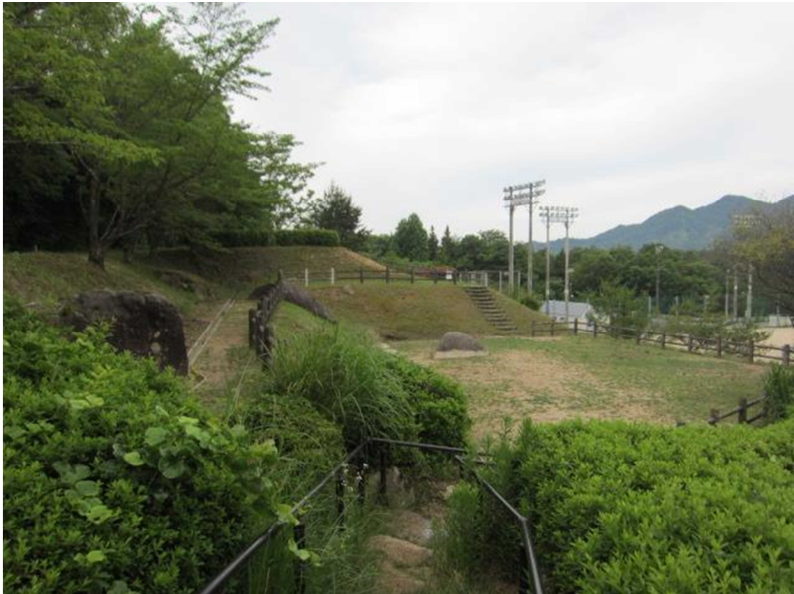
(復旧工事が完了した多目的グラウンドの様子)
