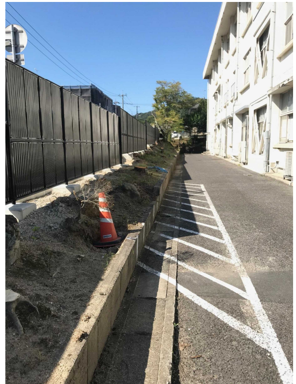
(工事途中：樹木の伐採を終えた状況)
