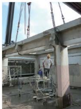
ワイヤーソーによる柱・梁の切断状況。建替えだと通常2,000トン近いコンクリート残骸が出るところを360トンに抑えた。
