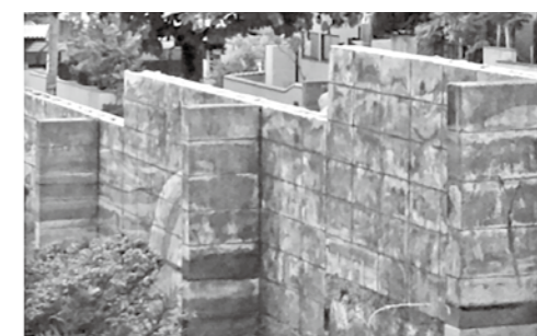
▲「ブロック塀改修工事現場」を視察
