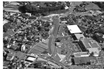
▲県道矢野安浦線バイパスの供用開始区間
