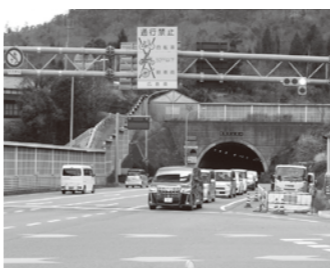
▲広島熊野トンネル
