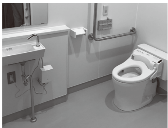
※写真は令和4年度に行った熊野東中学校の洋式化工事完了後のものです。
