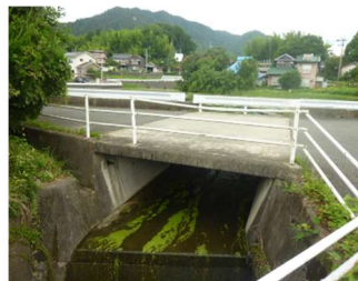
中郷原西ヶ廻1号橋 L=4m (RC橋) 1993 年架設
