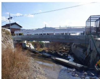
慶神橋 L=15m (鋼橋) 2020 年架設 (架替)
