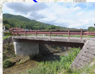
時山橋 L=10.5m (鋼橋) 1972 年架設
