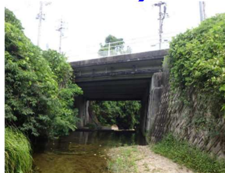
熊野押込橋 L=10.5m (RC橋) 1967 年架設
