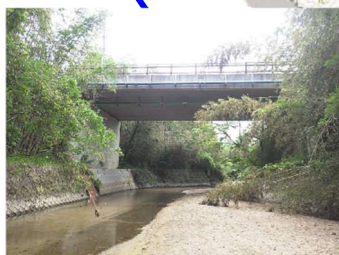
さくらの橋 L=36m (PC橋) 1996 年架設
