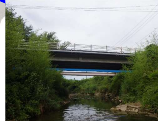
こで橋 L=21.6m (PC橋) 1981 年架設
