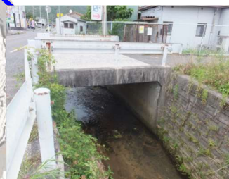
稻荷橋 L=4.1m (BOX) 1975 年架設
