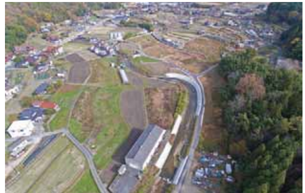
復旧状況 令和2年(2020)11月24日時点
