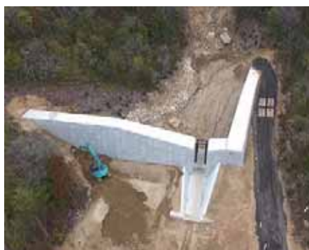
工事完了(令和元年12月18日)
