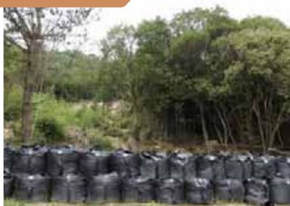
撮影：8月4日 今だに爪痕が残る災害現場。大型土のうによる応急対策が今だに続く。
