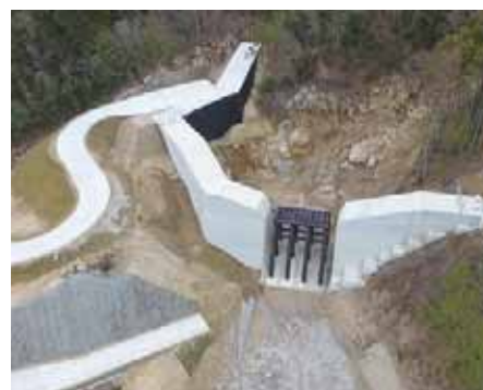
工事完了(令和元年12月3日)
