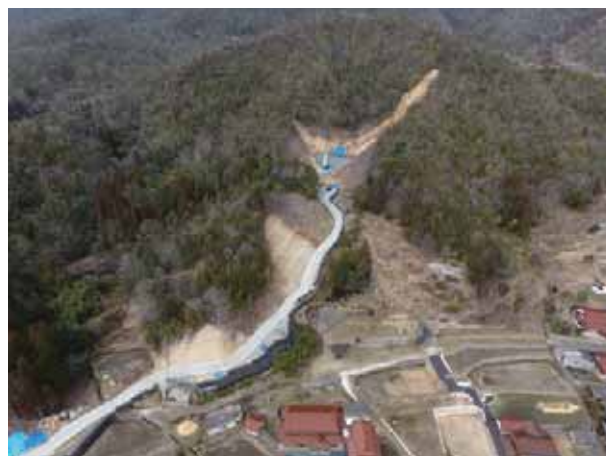
熊野川支川の砂防ダム(新宮地区)
