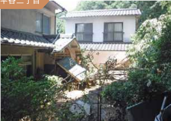
裏山でがけ崩れが発生し、流れ出した土砂が家屋に押し寄せました。平谷地区でも数件で家屋被害が発生しました。
