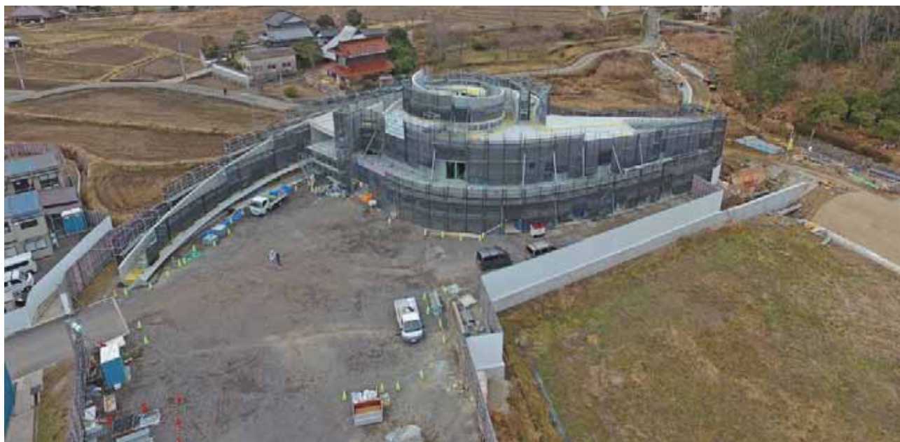
熊野東防災交流センター
