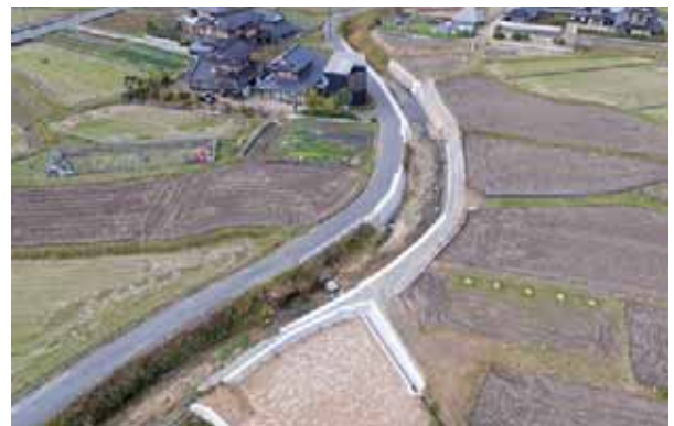
復旧状況 令和2年(2020)11月24日時点
