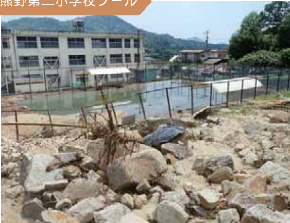
土石流により、プールの中にも土砂が堆積し、プールの周りには大きな石が転がっています。
