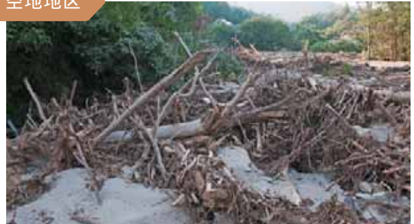
撮影：2018年7月16日 》 川底がフラットなコンクリートの上に土砂流木が2m以上堆積。
