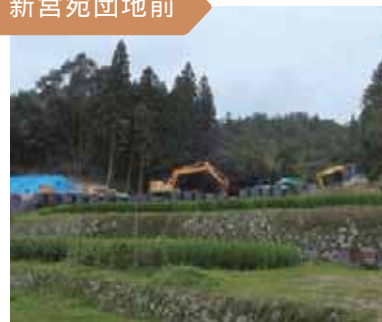
撮影：8月4日 砂防ダム工事の付替道路工事中。
