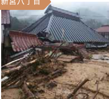
裏山からの大量の土石流。
