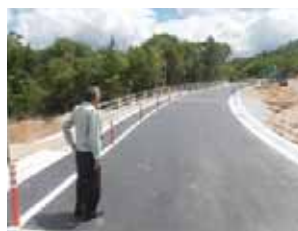
開通した避難路 (本設道路)
