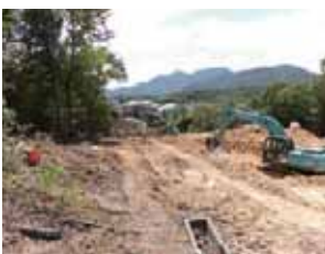
平成30年7月31日 大原仮設避難路造成開始
