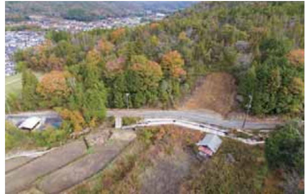
復旧状況 令和2年(2020)11月24日時点
