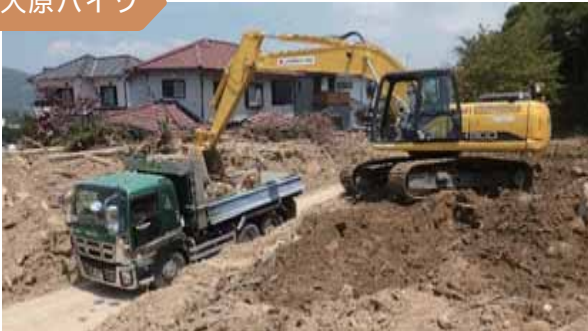
撮影：2018年 災害土砂撤去。
