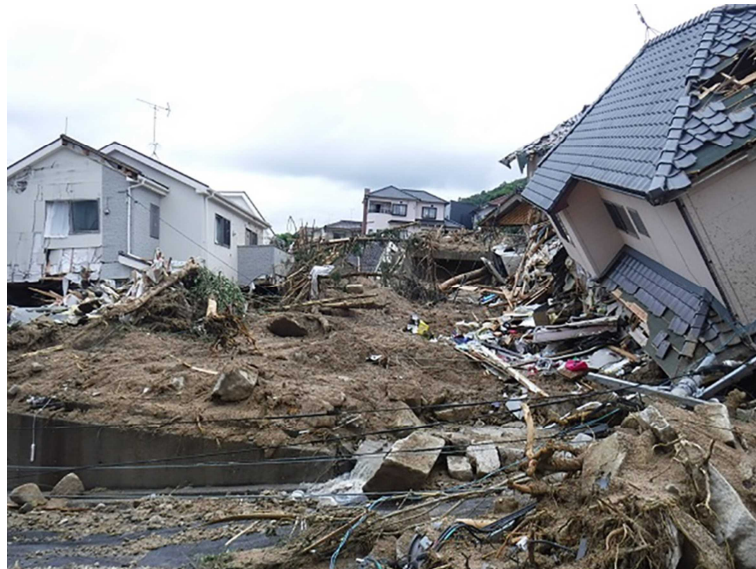
写真 大原ハイツの土石流現場
