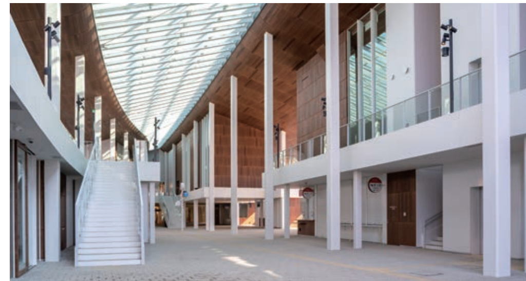
厳島港宮島口地区旅客フェリーターミナル
