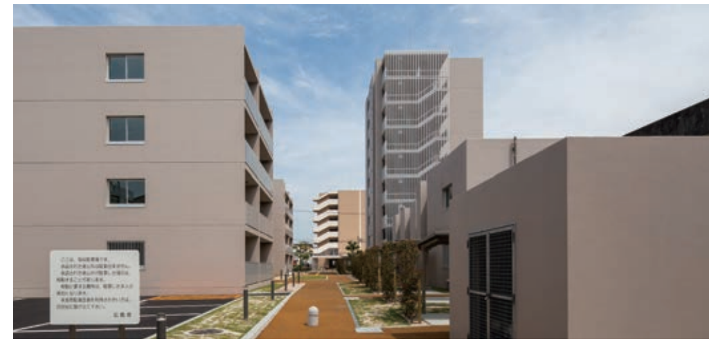
広島県営吉島住宅 21・22号
