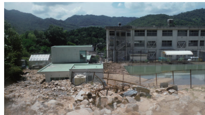
図57 第二小学校校舎側被災状況
