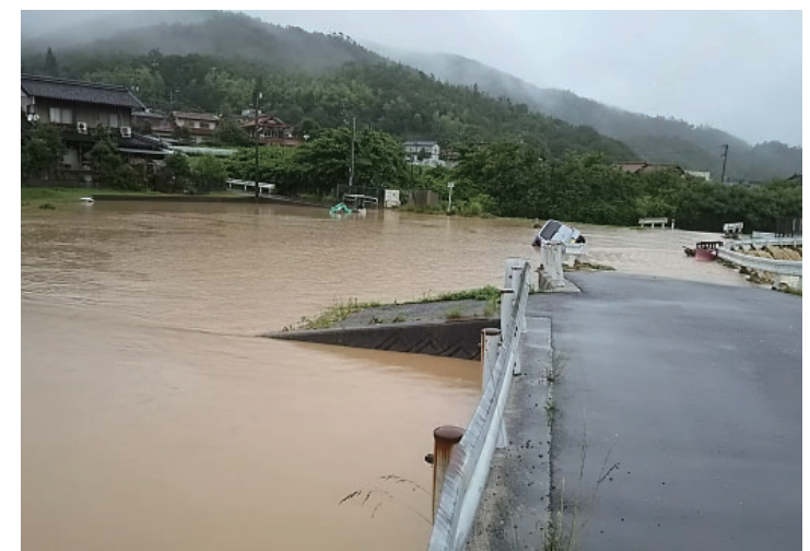
図51 新宮熊野川破堤被災
